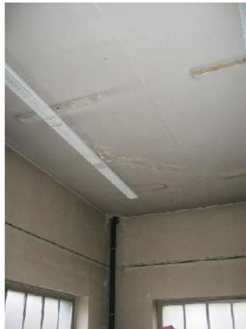
Viesville - Infiltrations d'eau
