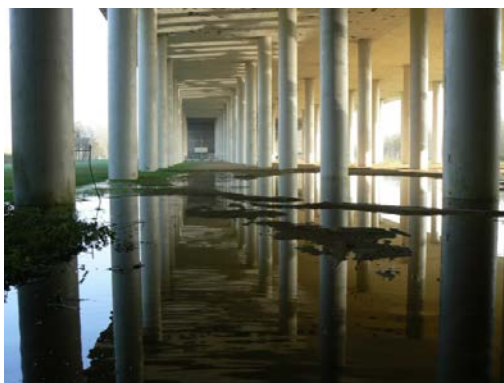
Venues d'eau généralisées sous le pont-canal
