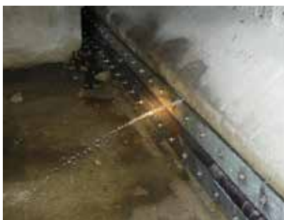
Fuites d'eau à l'intérieur des bajoyers (caissons communicants) et des caissons du radier
