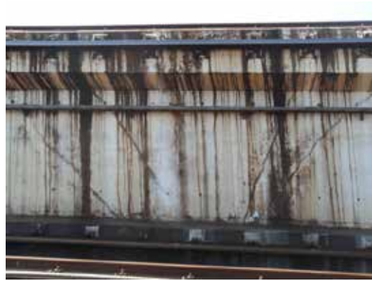
Fissuration à 45° des faces verticales des trémies de la partie aérienne.
