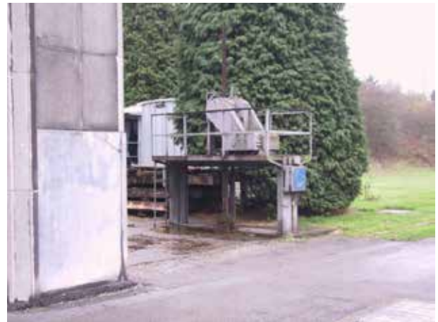
Gosselies - Évacuateur de crue
