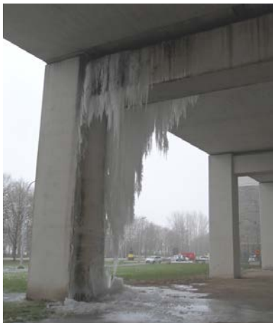
Dispositifs de récoltes des eaux et égouttage encrassés et/ou cassés.
