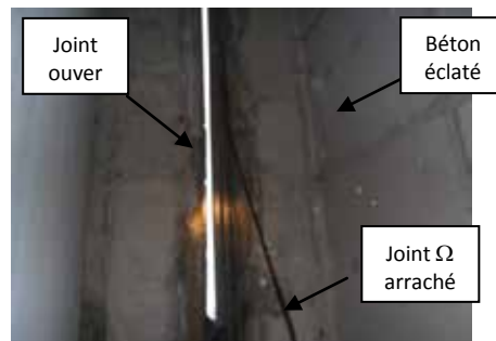
Fuites d'eau à l'intérieur des bajoyers (caissons communicants) et des caissons du radier
