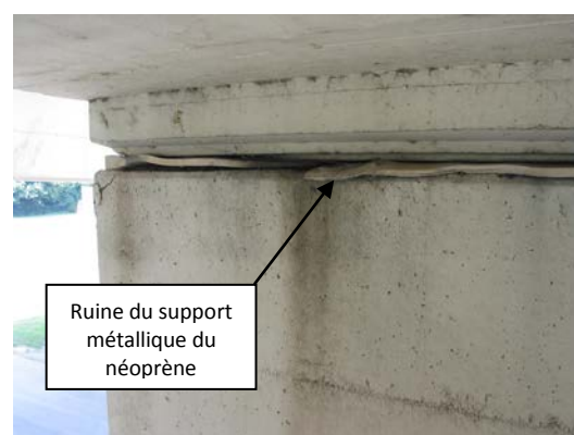
Ruine des appuis en néoprène/métal des trémies de la partie aérienne.
