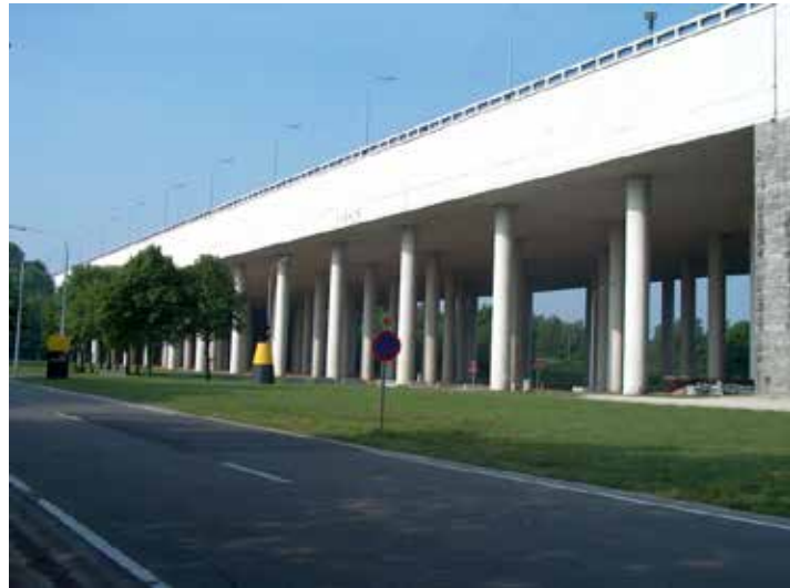
Le pont-canal vu depuis la route Baccara au pied de la tour
