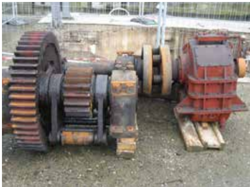
Gosselies - Treuil de vanne démonté
